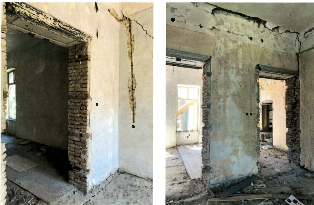
Fig.37., 38. Degradări structurale și la nivel de finisaj la etaj
