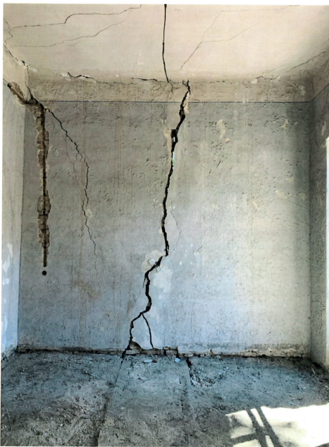
Fig.12. Fisuri adânci în pereții încăperilor de la etaj Sursa: arhiva Companiei Municipale pentru Dezvoltare Durabilă, București
