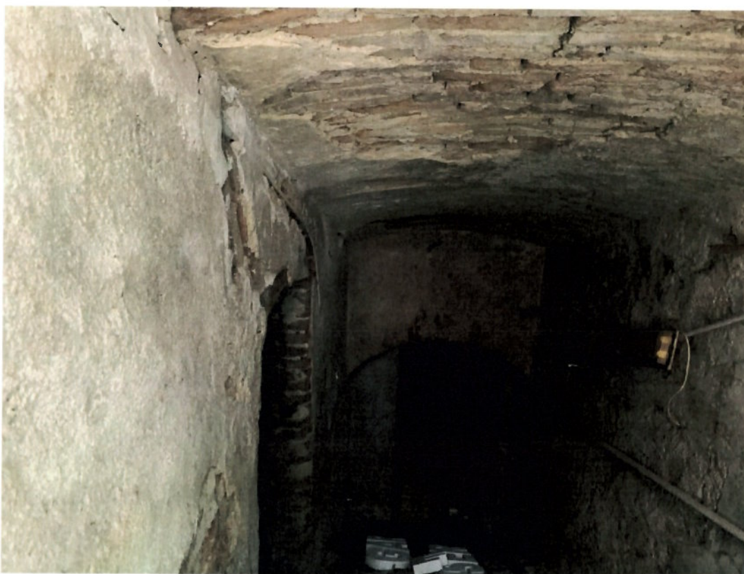
Fig.8. Infiltrații de apă în pereții subsolului
