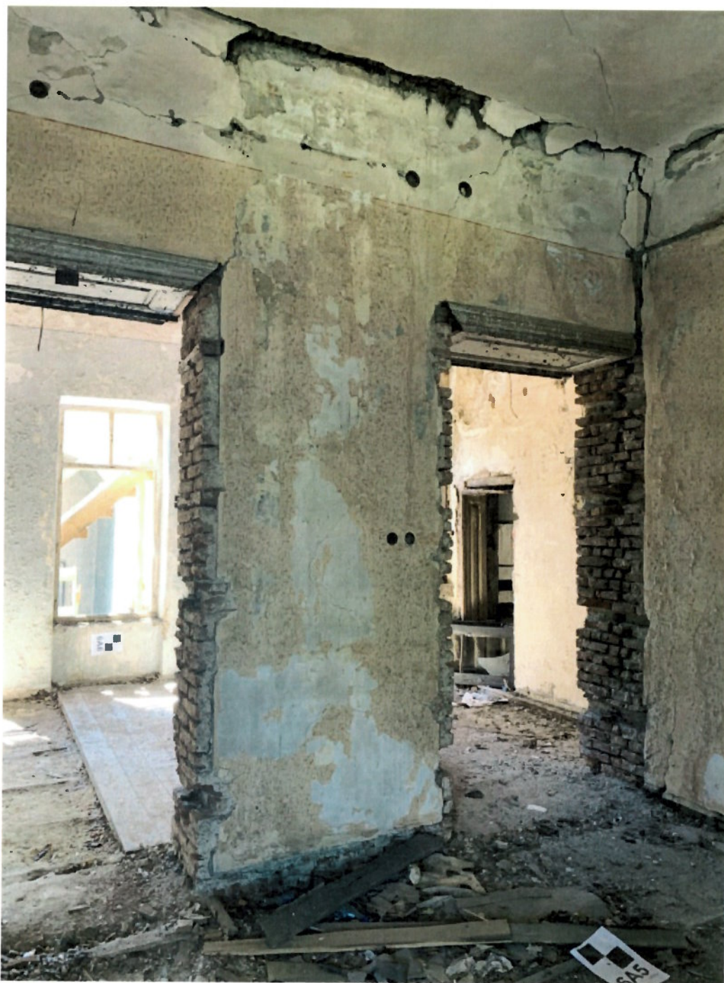
Fig.13. Degradări structurale și la nivel de finisaj la etaj
