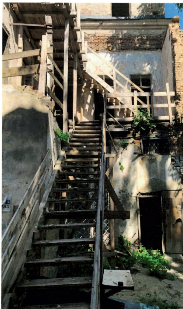
Fig.26. Degradări severe ale fațadei posterioare (sud-est); cursiva din lemn care asigură accesul la etaj
