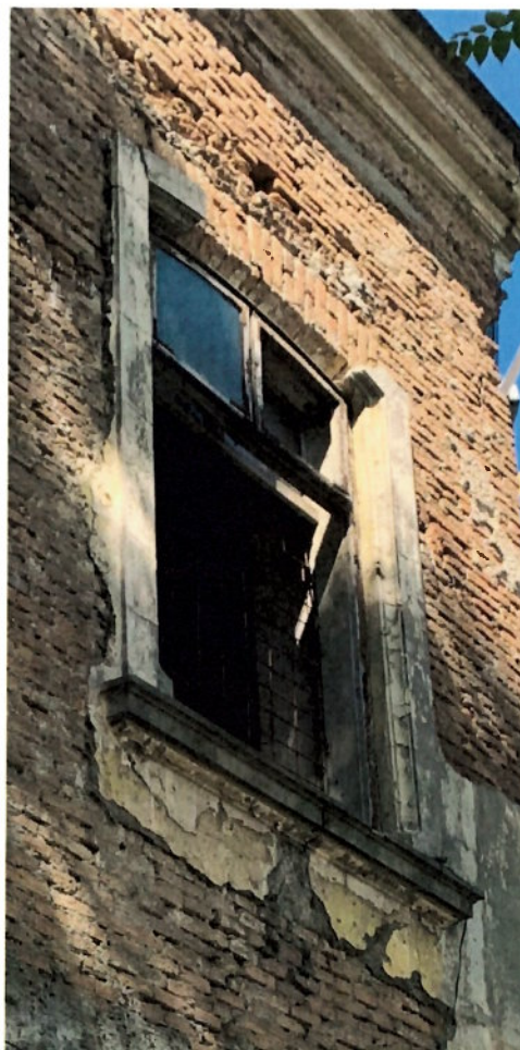
Fig.22. Fereastră cu ancadrament posibil cu cheie de boltă decorativă în formă de trapez răsturnat și solbanc din tencuială trasă cu profil dreptunghiular (detaliu fațadă laterală stânga)
