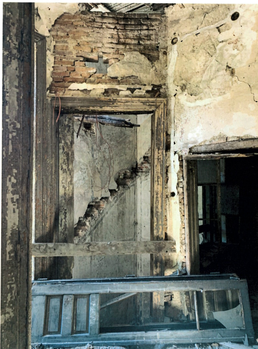
Fig.15. Urmele scării din beton armat, toc de uşă profilat din lemn (posibil original), tâmplărie degradată Sursa: arhiva Companiei Municipale pentru Dezvoltare Durabilă, Bucureşti
