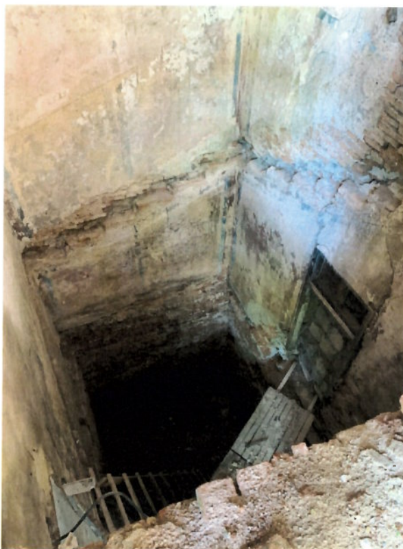
Fig.10. Casa scării – urmele scării din beton armat astăzi distrusă lăsate în pereții de zidărie Sursa: arhiva Companiei Municipale pentru Dezvoltare Durabilă, București
