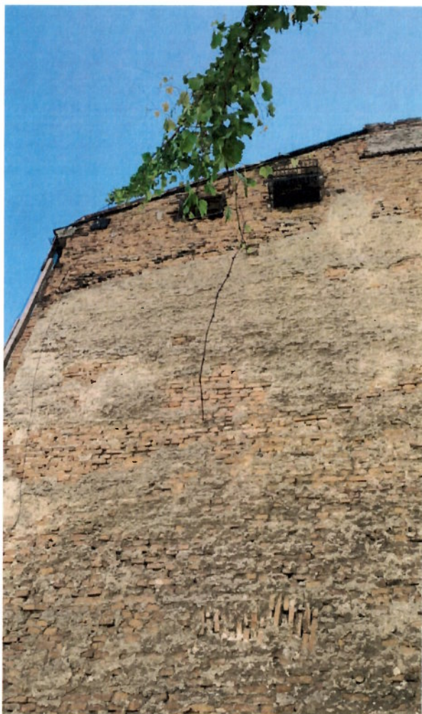
Fig.25. Fisuri adânci în peretele lateral (de vest) al clădirii; urme ale alipirii la calcan cu o clădire astăzi dispărută
