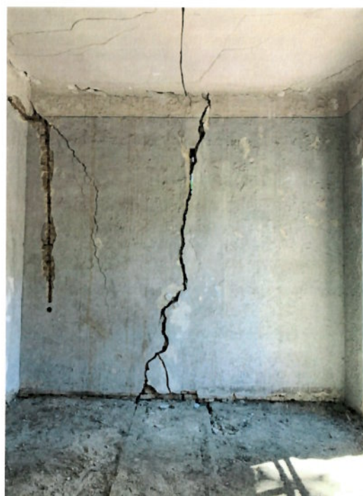
Fig.36. Fisuri adânci în pereții încăperilor de la etaj Sursa: arhiva Companiei Municipale pentru Dezvoltare Durabilă, București
