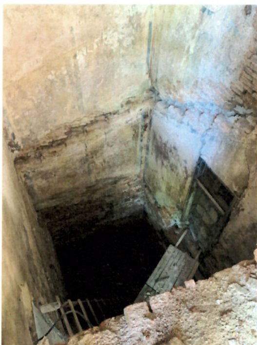
Fig.35. Casa scării – urmele scării din beton armat astăzi distrusă lăsate în pereții de zidărie Sursa: arhiva Companiei Municipale pentru Dezvoltare Durabilă, București
