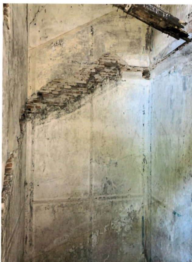
Fig.9. Casa scării – urmele scării din beton armat astăzi distrusă lăsate în pereții de zidărie
