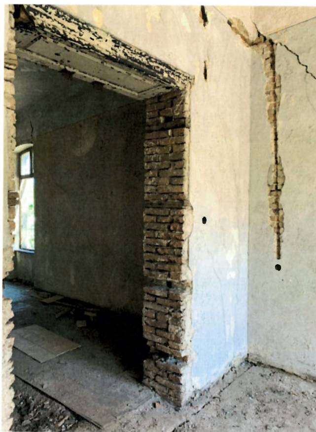
Fig.11. Degradări structurale și la nivel de finisaj la etaj Sursa: arhiva Companiei Municipale pentru Dezvoltare Durabilă, București
