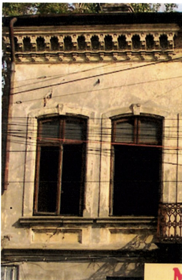
Fig.21. Ferestre cu ancadrament cu cheie de boltă decorativă în formă de trapez răsturnat, solbanc din tencuială trasă cu profil dreptunghiular; decorație sub fereastră cu panou dreptunghiular săpat în zidărie (detaliu fațada principală)
