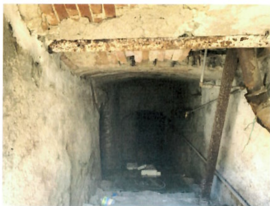
Fig.27., 28. Infiltrații de apă în pereții subsolului
