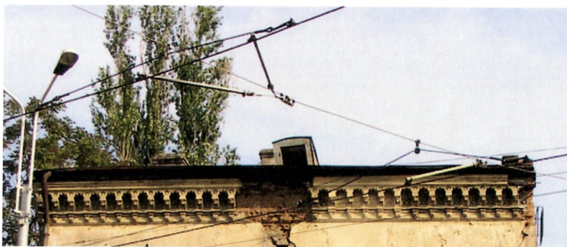
Fig.20. Cornișa cu consolete decorative cu arcade polilobate de factură otomană
