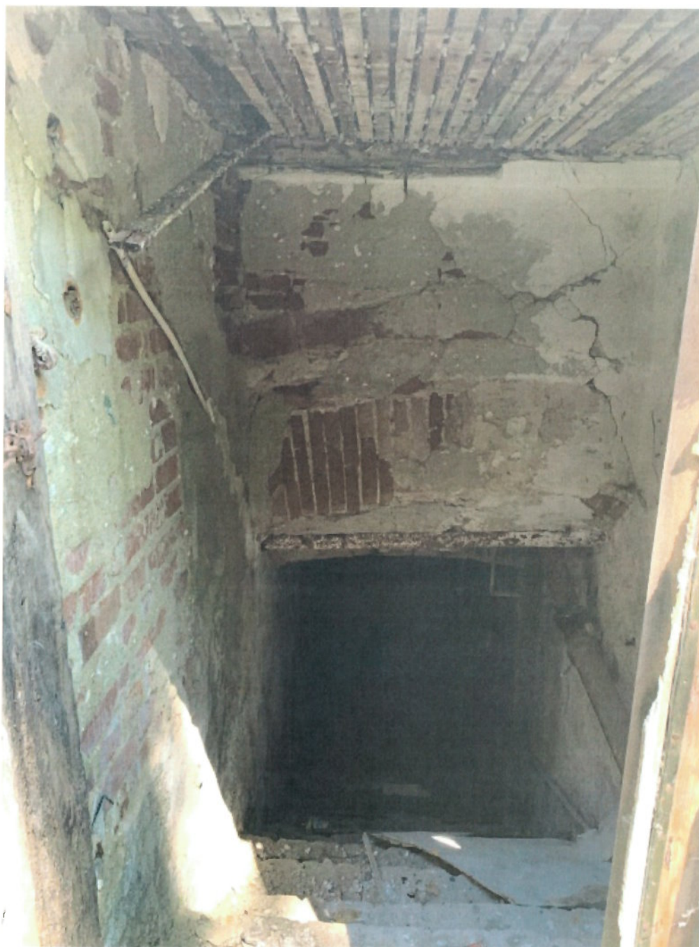
Fig.7. Infiltrații de apă în pereții subsolului
